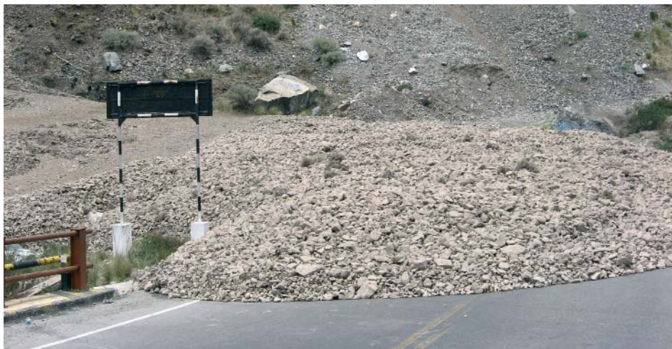
Derrumbamentos en carreteras
