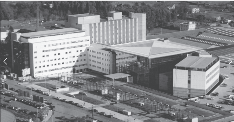
Hospital Arquitecto Marceide co centro de especialidades.
